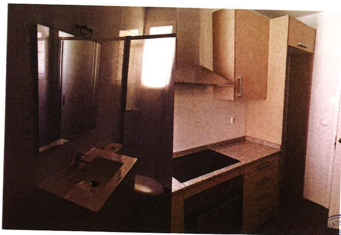
Rehabilitacions a Cea Bermúdez, 15 (Madrid)
