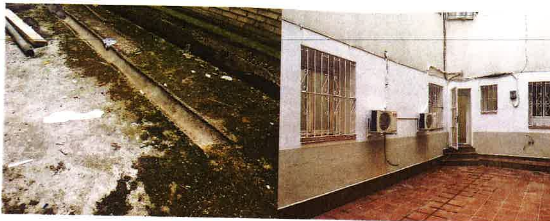
Rehabilitació a Avenida Mediterráneo, 35 (Madrid)
